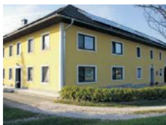
Der Betrieb Prötsch, vulgo Ortner, liegt in Roitham.
